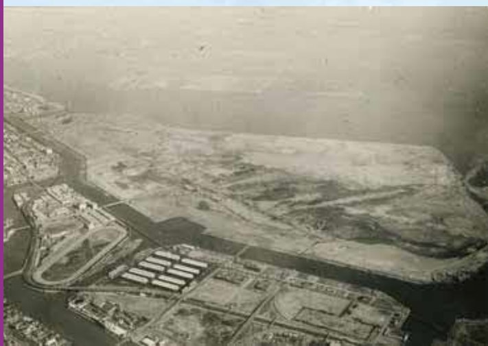
埋め立て中の大井埠頭 (東京都港湾振興協会提供 パネル展示)
