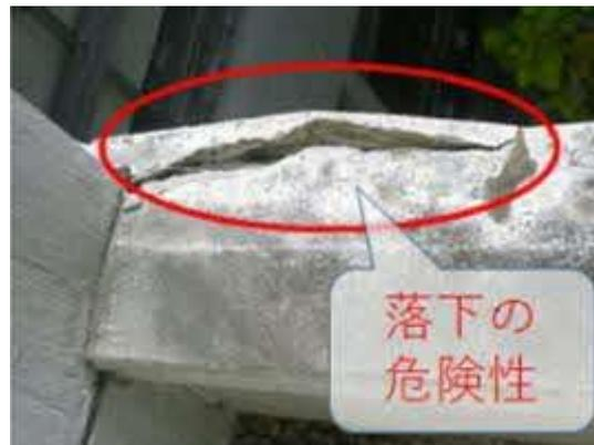
コンクリートはアルカリ性の物質で、酸性に弱い内部の鉄筋が錆びるのを防ぐ役割を持っている。しかし中性化が進むと、中の鉄筋が錆びて地震等への安全性を確保できなくなる（出典：宮城県仙台市）
