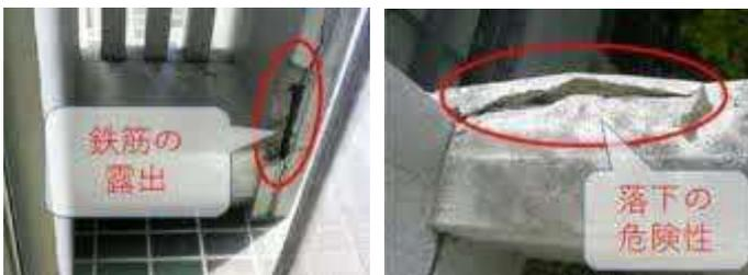
コンクリートはアルカリ性の物質で、酸性に弱い内部の鉄筋が錆びるのを防ぐ役割を持っている。しかし中性化が進むと、中の鉄筋が錆びて地震等への安全性を確保できなくなる
