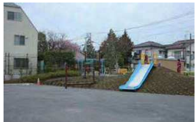
二葉公園整備
