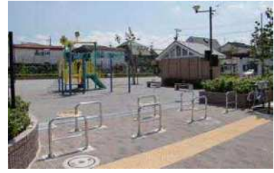
ゆたか防災広場整備
