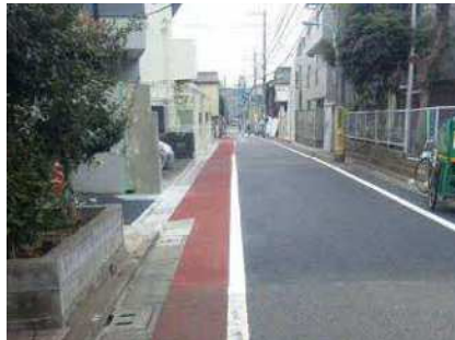
地区防災道路(大原通り)拡幅整備
