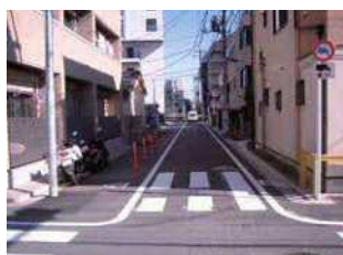
荏原文化センター通り拡張整備
