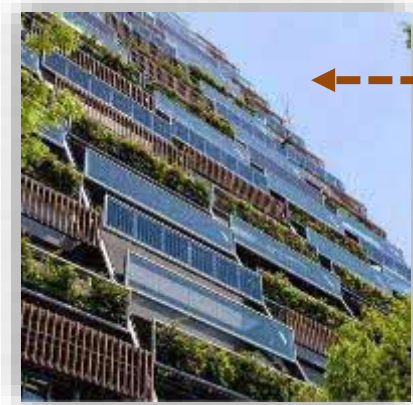
エコヴェール：太陽光発電 パネル、緑化パネルで構成 (出典：豊島区)
