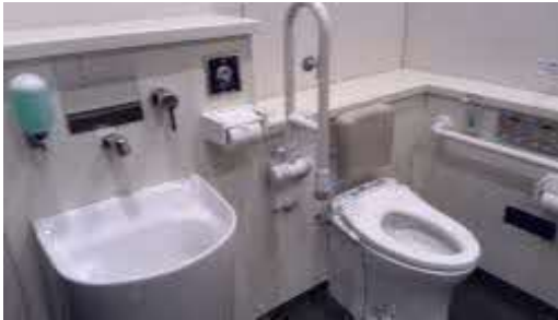
オストメイト用トイレ、ベビーチェア等を設けた多機能トイレ (出典：豊島区)
