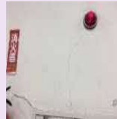
③ひび割れた壁
