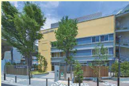
鮫浜小学校新校舎(令和3年7月完成)
