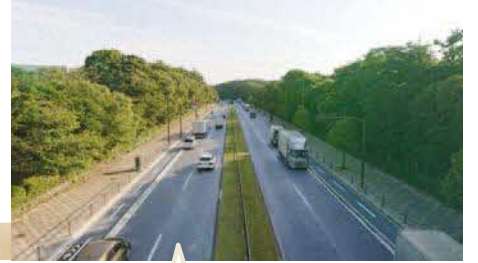
無電柱化した東京2020オリンピック・パラリンピック施設周辺道路
