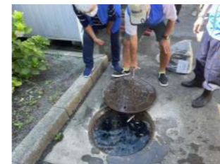
○西大井四丁目町会 貯水槽蓋開け確認
