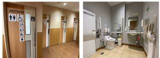
図表 3-16 誰もが利用しやすいトイレの整備事例 (出典：国交省「共生社会におけるトイレの環境整備に関する調査研究」)
