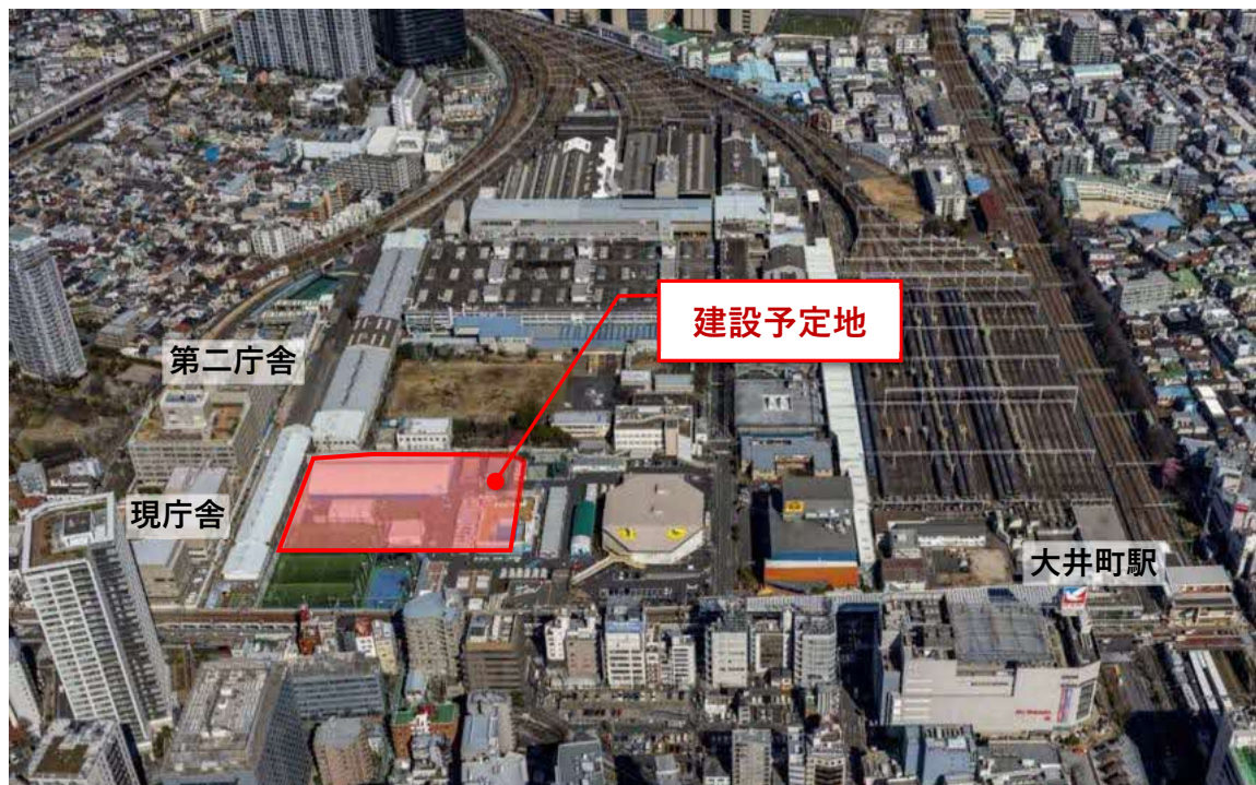
図表 3-2 建設予定地の現況
