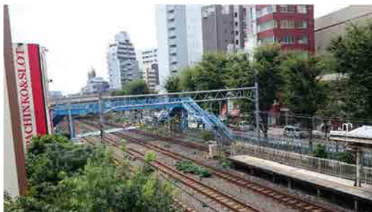
大井町跨線橋
