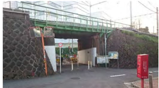
長者丸踏切（奥）とガード（手前）
