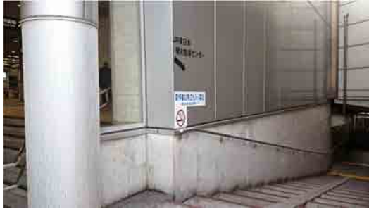
JR施設連絡通路
