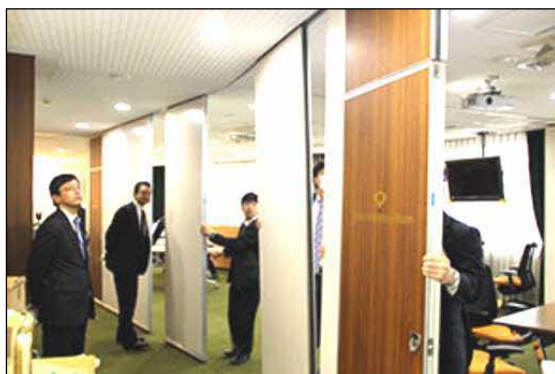
a) 会議室のパーティションの撤去
