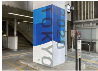
立会川駅橋脚
