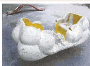
スイング遊具 塗装が剥けている
