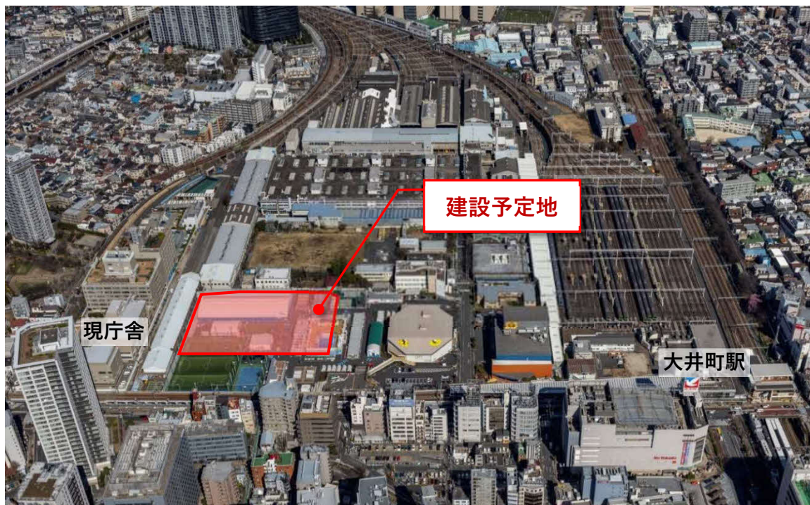
図表 3-2 建設予定地の現況
