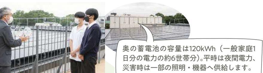
奥の蓄電池の容量は120kWh(一般家庭1日分の電力の約6世帯分)。平時は夜間電力、災害時は一部の照明・機器へ供給します。
