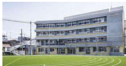
鮫浜小学校新校舎 (4年5月全工完了)
