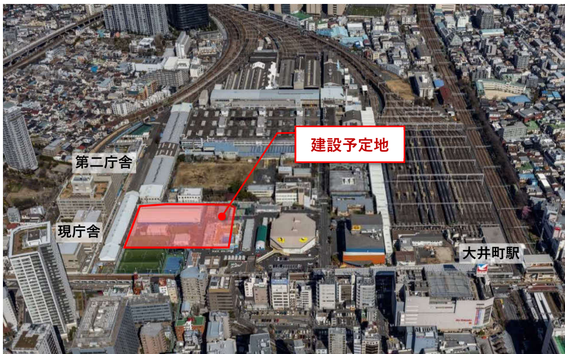
図表 3-2 建設予定地の現況
