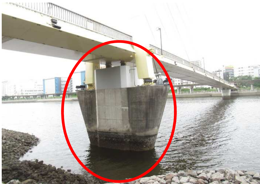
かもめ橋 橋脚
