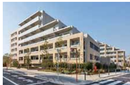
老朽建築物の除却と共同住宅の整備
