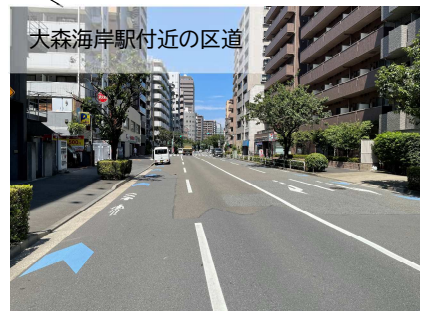
図 5-9 自転車ネットワーク路線と自転車通行空間整備の例
