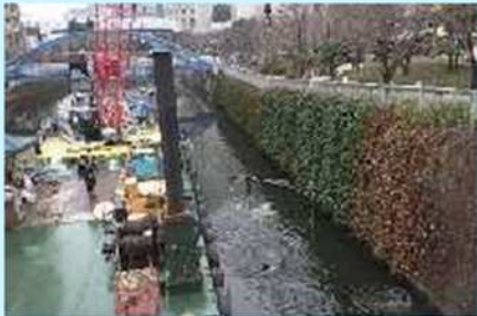
障害物撤去実施状況(⑫)
