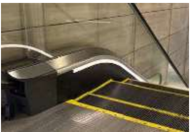
巻き込み防止を確保した事例
