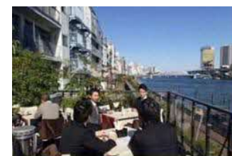
かわてらす®設置状況 (隅田川) 出典:東京都建設局HP
