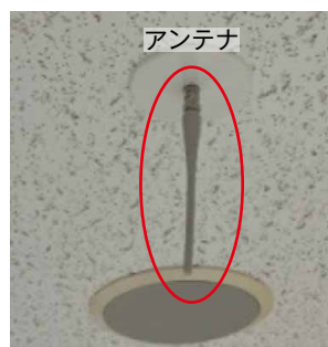
《図2》天井下方向の設置例
