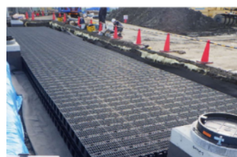
雨水貯留浸透施設整備事例
