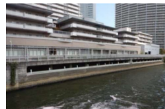
荏原調節池取水部
