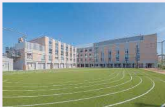
浜川小学校新校舎（7月全工事完了）
