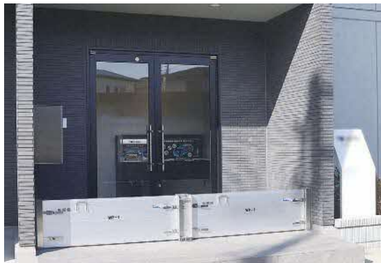
止水板設置時の様子
