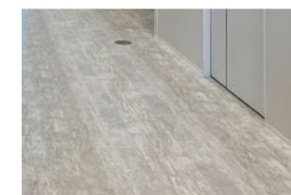
ビニル系床材の事例
