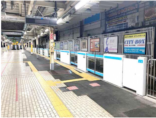
可動式ホーム柵の設置(大井町駅)
