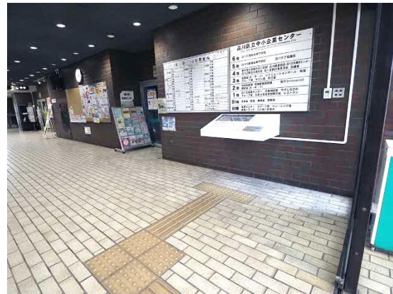
案内設備までの点字ブロックの整備 (区立中小企業センター)
