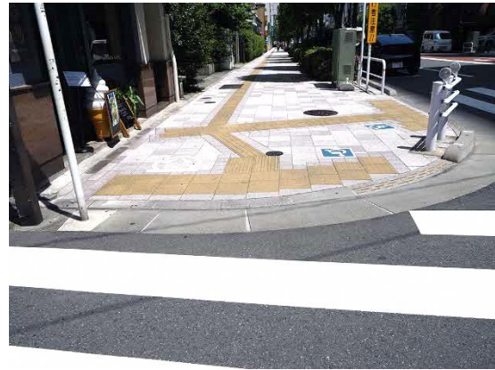
歩道のセミフラット化・点字ブロックの整備 (通称どんたく通り)
