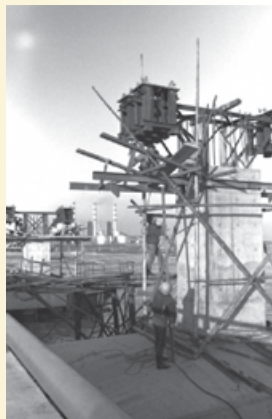
工事中の首都高速1号(昭和38年)
