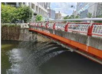
御成橋からの再生水散水の様子
