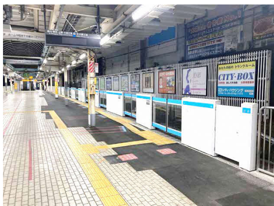
可動式ホーム柵の設置(大井町駅)
