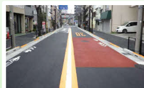
セミフラット化された ゼームス坂通り
