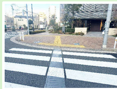
大井町駅入口交差点のエスコートゾーン
