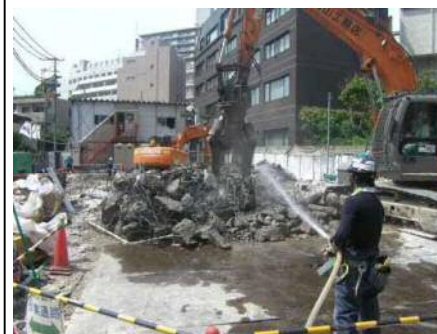
粉塵飛散防止対策用 散水状況
