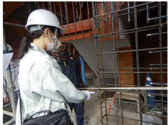
耐震改修工事の中間検査の様子
