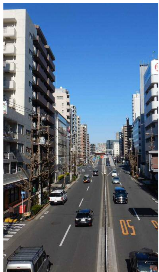
品川区内の特定緊急輸送道路の様子 (中原街道)
