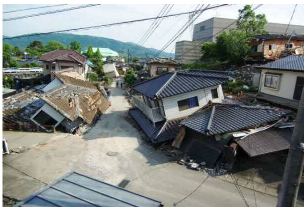
平成 28(2016)年熊本地震における益城町寺迫周辺の被害
