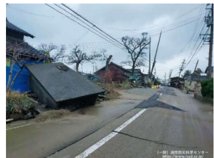
令和6(2024)年 能登半島地震の 建物被害
