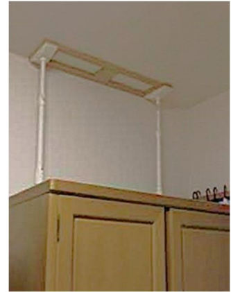
転倒防止対策を行った様子
