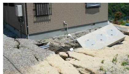
液状化による被害
