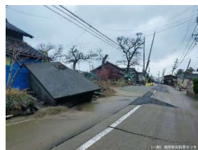
令和6(2024)年 能登半島地震の建物被害
