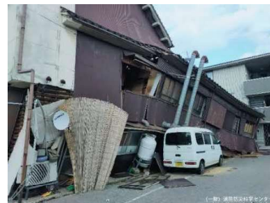
令和6(2024)年 能登半島地震の建物被害
