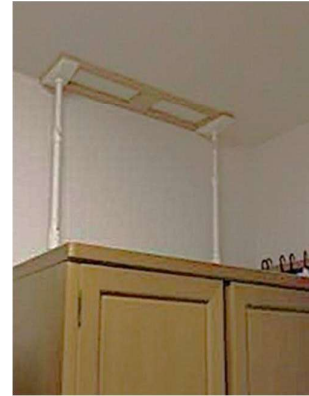
転倒防止対策を行った様子
