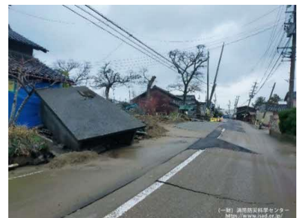
令和6(2024)年 能登半島地震の 建物被害
