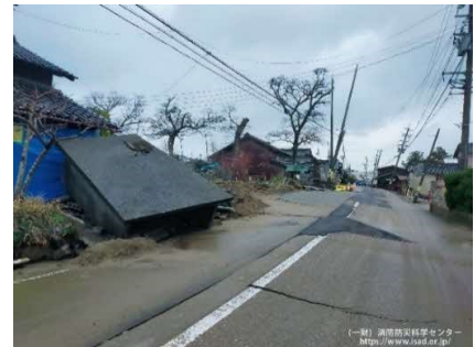
令和6(2024)年 能登半島地震の 建物被害
