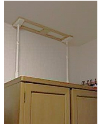
転倒防止対策を行った様子
