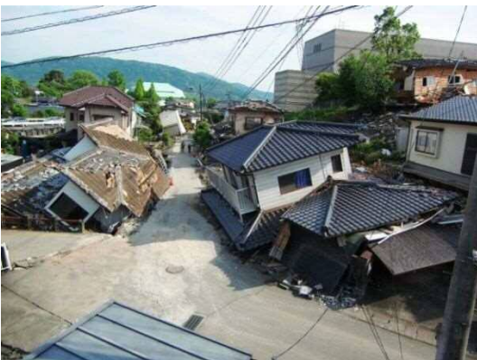
平成 28(2016)年熊本地震における益城町寺迫周辺の被害 出典：熊本県「熊本地震デジタルアーカイブ」
