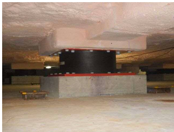
品川区役所本庁舎の免震装置*の設置
