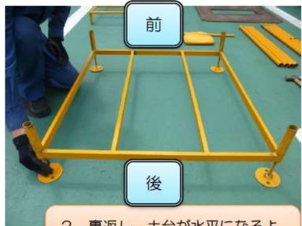
2. 裏返し、土台が水平になるようにジャッキを調整する
