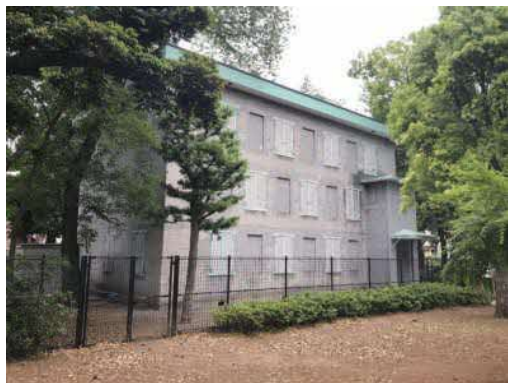
関東大震災後の防火対策で、窓が半分ふさがれています
