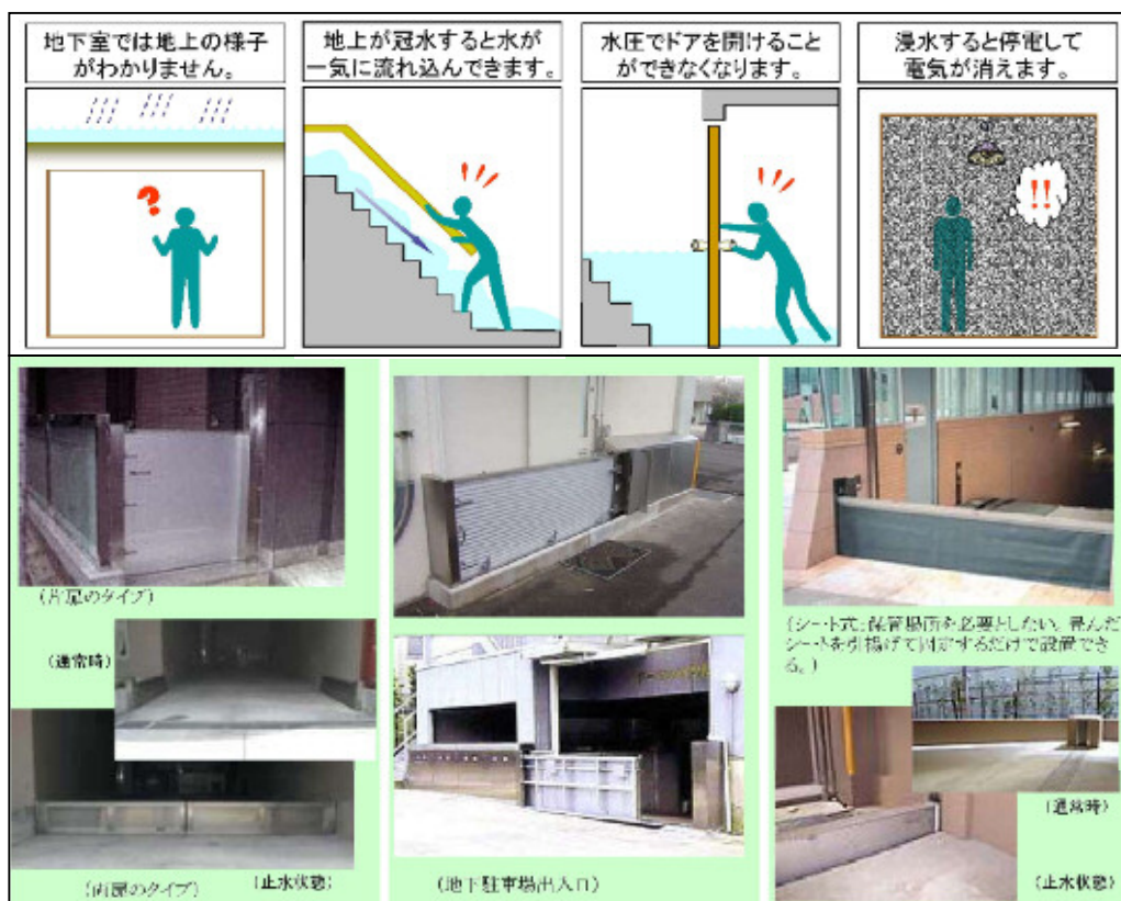
図 5-6 地下空間の危険性と防止板の設置イメージ
